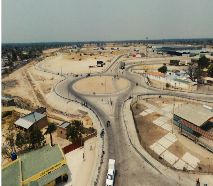
Figura C.23 - Parque Aduaneiro da AGT do Posto Fronteiriço de Santa Clara (Angola).
