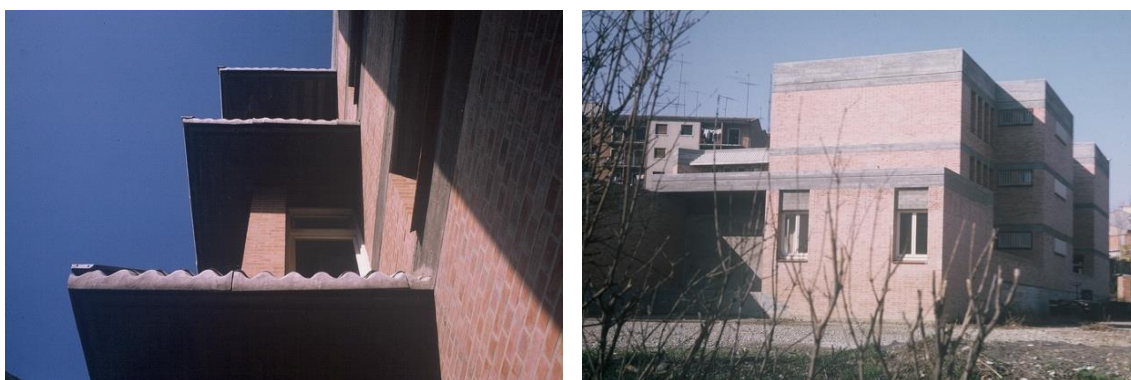
Figura 12. Detalles de voladizos y retranqueos de fachadas de la fase 1 del colegio de las Salesianas. Diapositivas del archivo de Juan Carmona.
