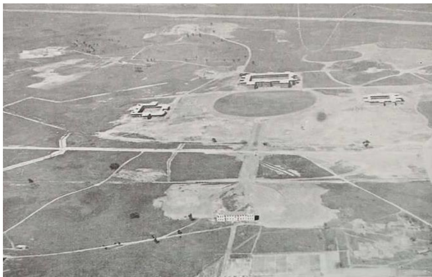
Figura 1 - Vista aérea do campus em construção, c.1940. Memórias de Itaguaí . [em linha]. Itaguaí: s.n. [Consult.: 12/05/2021]. Disponível na Internet: URL < https://www.facebook.com/memoriasdeitaguaui/photos/1132675883540632 >
