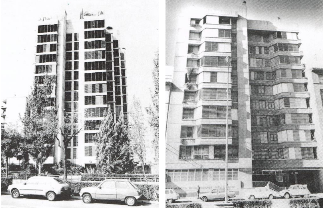
Figura 5. Edificios de viviendas de Cooperativa de Belén (José Romero y Saturnino Cisneros) a la izquierda y edificio de viviendas en Avenida Goya (Juan Carmona y José María Mateo). Fuente: CARMONA, J.A. - Grupo Z. Quince años de supervivencia. Revista Aldaba, 1981, 1.
