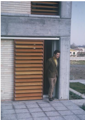
Figura 16. Detalles de lamas de control solar de las aulas y lucernario de la sala multiusos del noviciado de las Salesianas. Diapositivas del archivo de Juan Carmona.
