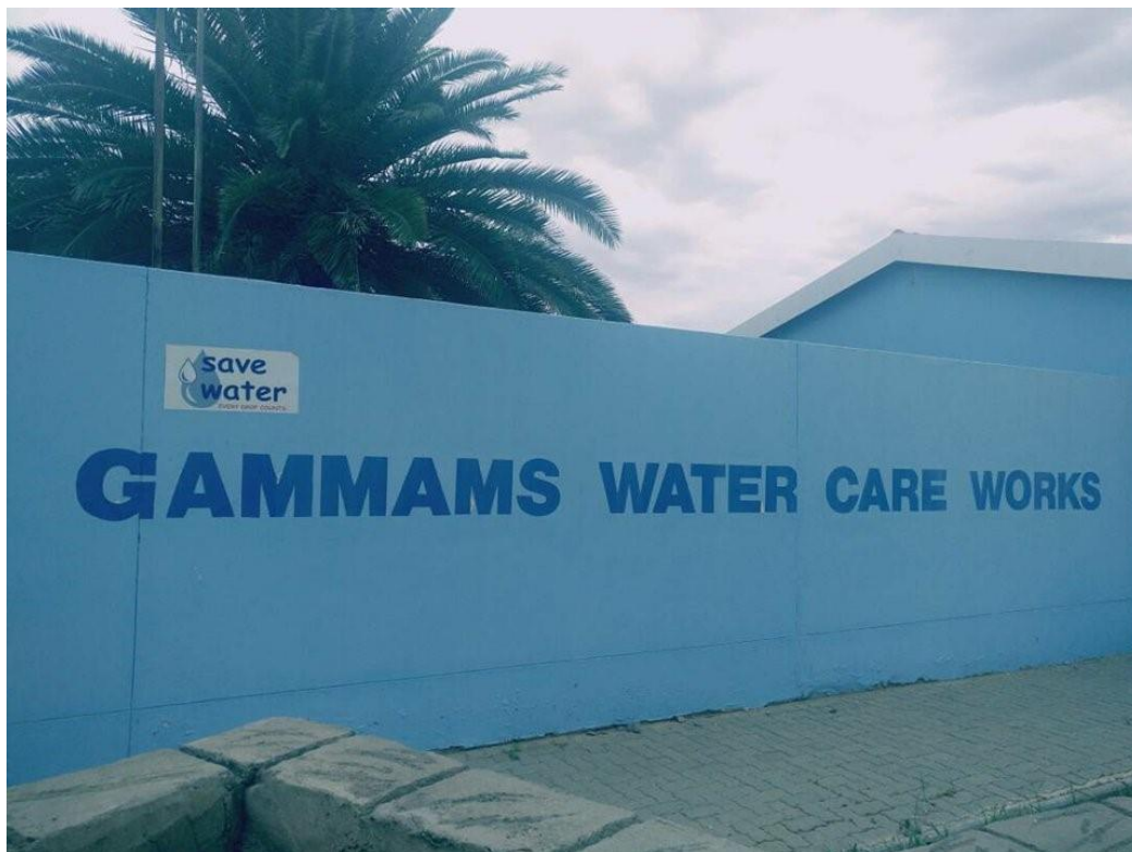
Figura 4.9 – Zona de tratamento Gammams Water Care Works, Namíbia
