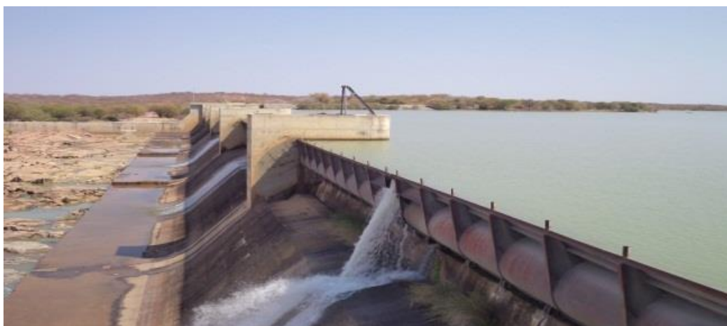
Figura 4.4 – Barragem do Ruacaná fornece energia eléctrica a uma parte do Norte da Namíbia e algumas localidades de Angola
