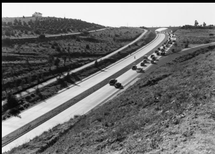
4. Registo Fotográfico da Auto Estrada 5 (A5), 1944
