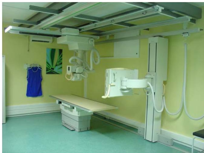
Figura 6 – Actual Sala 2 de Radiologia do CDP do Porto
