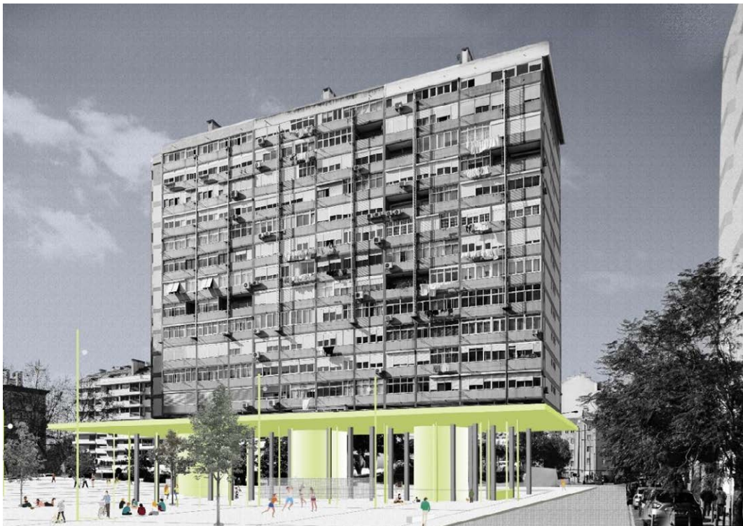
Figura 85 Edifício de habitação coletiva a intervir, (Arq. João Carmo Simões, 2020) Figura 86 Fotomontagem da proposta, (André Camilo | António Alves | Carolina See | Daniela Mangas | Duarte Guerreiro | Leonor Andrade, 2020)
