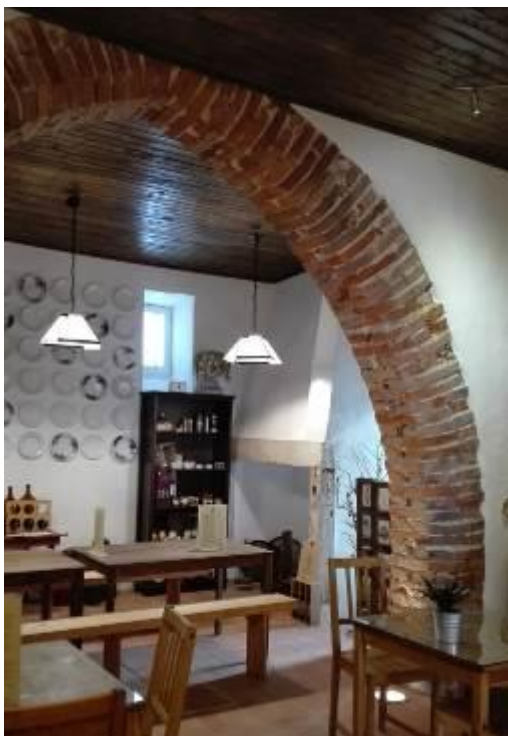
Fig. 10 – Arco chanfrado em tijolo na Rua do Arco de Santarém, nº14. Elaborado pela autora.
