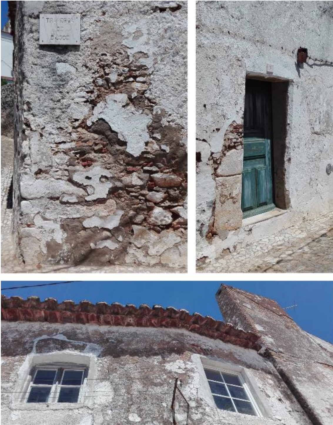
Figura 5 – Sentido horário: Cunhal entre a Tv. de S. José e Rua do Relógio, porta em mármore chanfrado nº 3, beirado e chaminé do alçado lateral. Elaborado pela autora.
