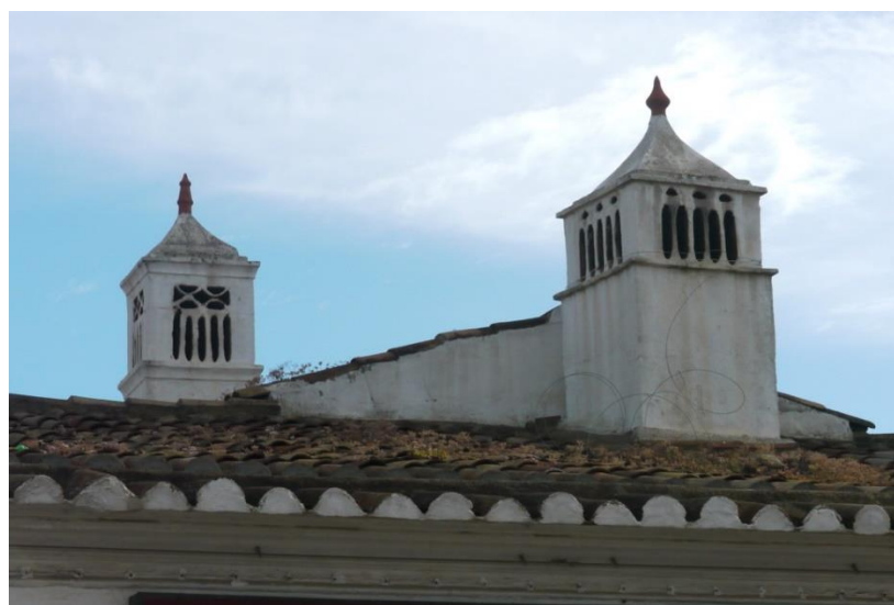
Figura 8 – Chaminés de grelha aparente em Alancil. Elaborado pelos autores
