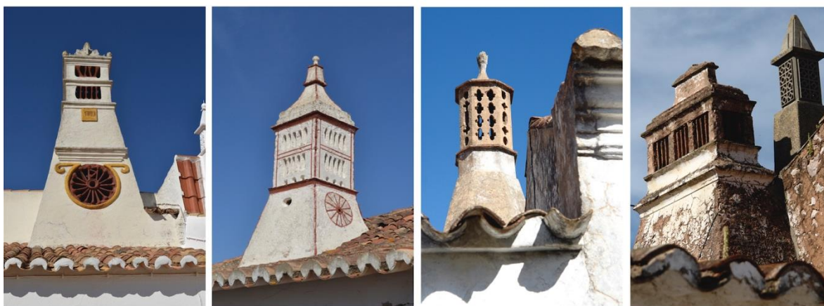
Figura 11 – Chaminés em Porches (a, b), chaminé em habitação dispersa, concelho de Olhão (c), e contraste de escalas de chaminés tradicional e industrial na Cumeada, concelho de Silves (d). Elaborado pelos autores
