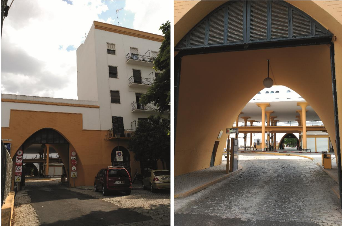
Figura 1 - Imágenes de las viviendas y estación de autobuses del Prado de San Sebastián, obra de Rodrigo Medina Benjumea. Fotografía de los autores
