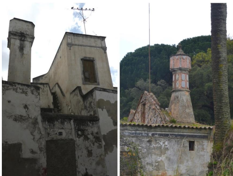
Figura 7 – Chaminé de balão em Olhão (a) e chaminé de saia em Monchique (b). Elaborado pelos autores
