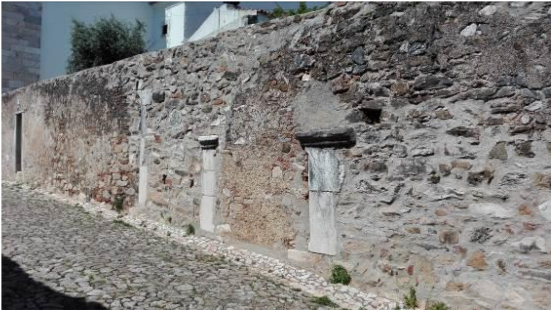
Figura 2 – Pórticos marmóreos embutidos no muro de delimitação do quintal. Pórtico ogival de fisionomia medieval (dir.) e arranque de pórtico manuelino (esq.). As peças em mármore são frequentemente removidas e transladados a outros locais. Elaborado pela autora.
