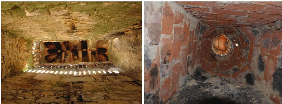
Figura 3 – Vista interior do apanha-fumos e chaminé em habitação dispersa no concelho de Faro (a) e na povoação de Cacela (b). Elaborado pelos autores
