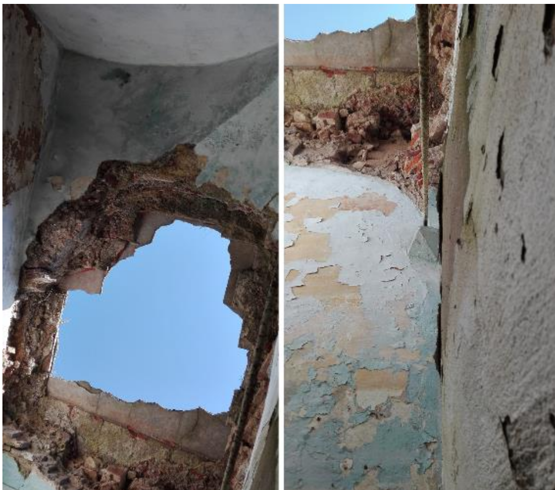
Figura 6 – Abóbada e mísulas, casa no nº1. Elaborado pela autora.
