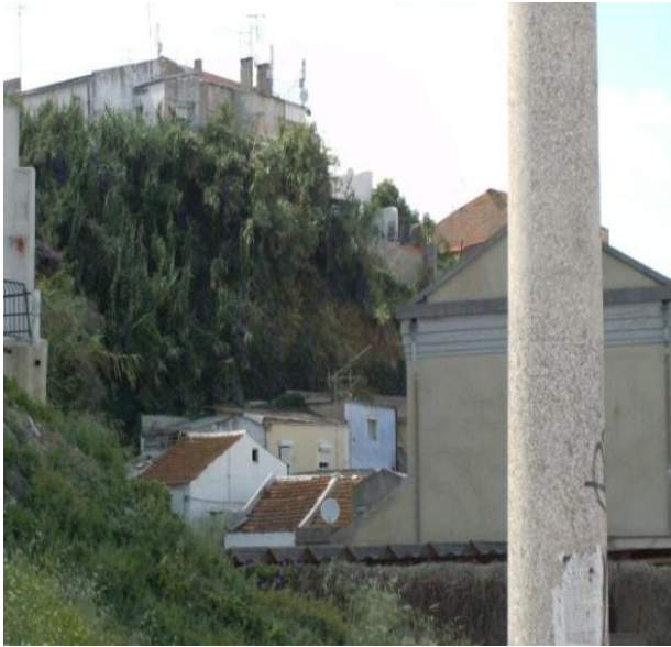
Legenda: Habitações em risco na Rua Inácio Pardelhas Sanches, junto às Escadinhas da Liberdade 118
