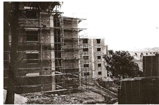
Legenda: Habitações em construção 64
