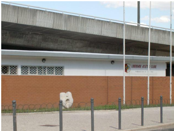
Legenda: Imagem do autor das actuais instalações do Liberdade Atlético Clube junto ao Eixo Norte-sul
