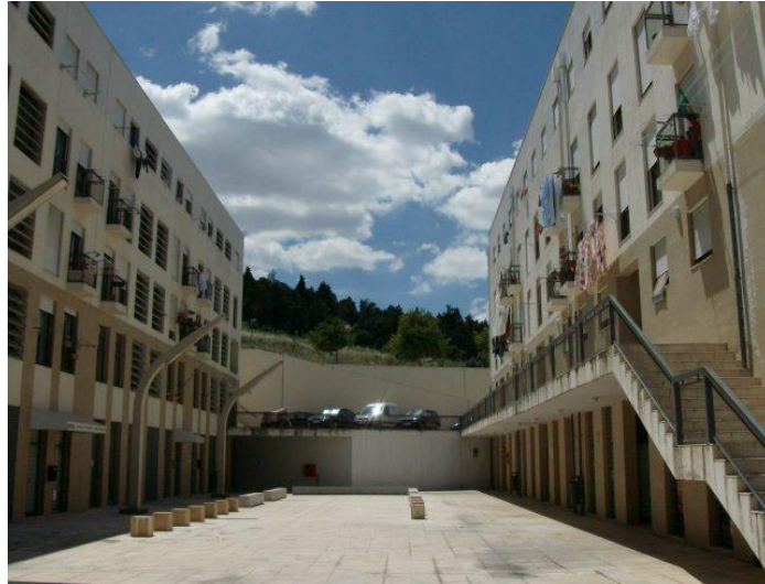
Legenda: Imagem de dois dos três blocos construídos em 2000 97
