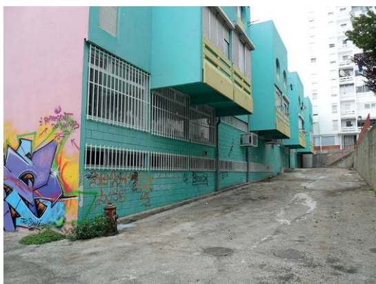
Figura 4 ▶ Piso térreo para a rua. Bairro do Condado, Zona J, Marvila, Lisboa
