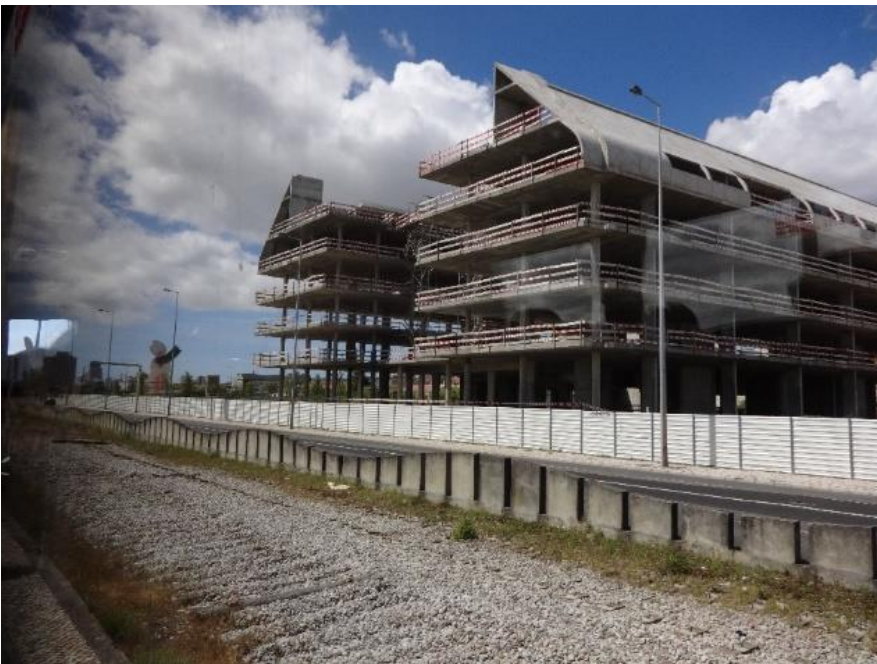
Figura 16 - Vista dos Jardins Braço de Prata, em construção, em Braço de Prata (Lisboa). (Fotografia do Arquivo de Ana Nevado; 2015).
