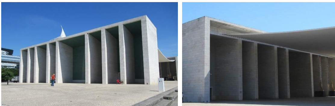
Figura 20 e 21 – Pilares de sustentação da catenária - ressonância dos contrafortes – Pavilhão de Portugal 2019 - Foto de Nuno Magalhães
