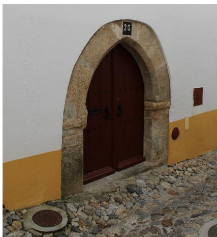
Figura 4 – Portal em arco apontado, Rua da Freiria de Baixo, Évora. Fotografia de Silvana Sousa. (2019)
