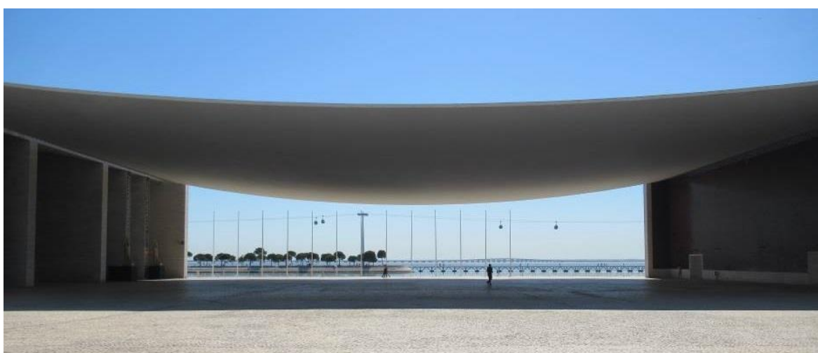
Figura 22 – Cobertura em catenária – ressonância do arco – Pavilhão de Portugal – 2019- Foto de Nuno Magalhães
