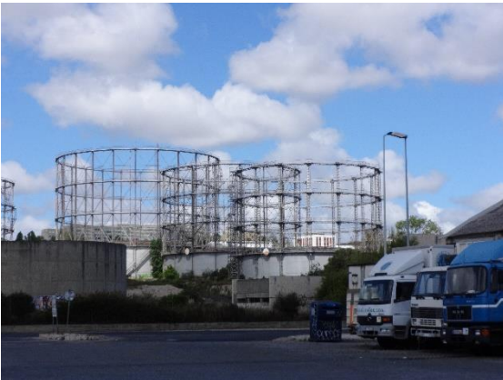
Figura 10 - Vista de 2 antigos gasómetros, em Cabo Ruivo (Lisboa). (Fotografia do Arquivo de Ana Nevado; 2015).
