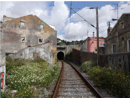
Figura 11 - Vista da linha ferroviária de transporte de mercadorias, em Xabregas (Lisboa). (Fotografia do Arquivo de Ana Nevado; 2014).
