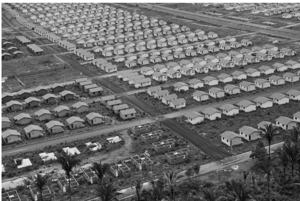
Figura 4. Imagem aérea do conjunto habitacional Residencial Jacinta Andrade durante sua construção (GP1, 2016).
