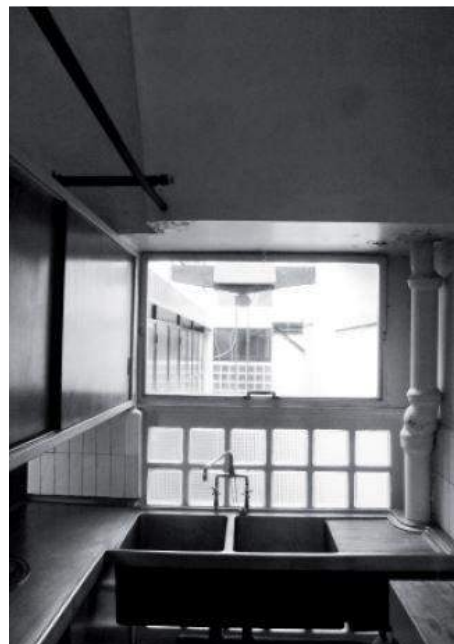
Figura 83 - Janela e superfície em pavés, assegurando a iluminação e ventilação natural
