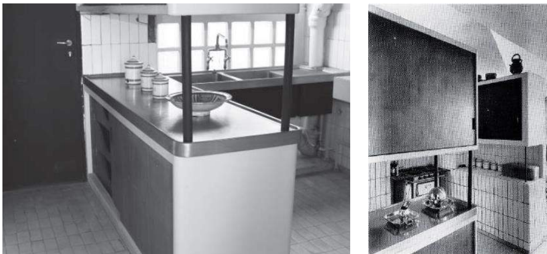
Figura 79 - Interior da cozinha, módulo passa pratos e módulos superior suspensos por tubos metálicos
