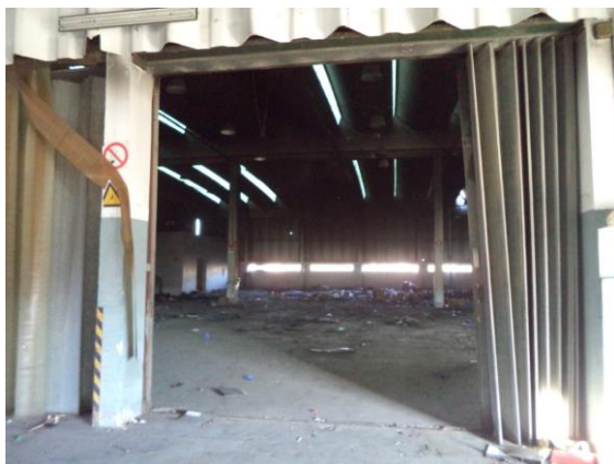
INTERIOR DO ARMAZÉM Entrada da Secção Norte
