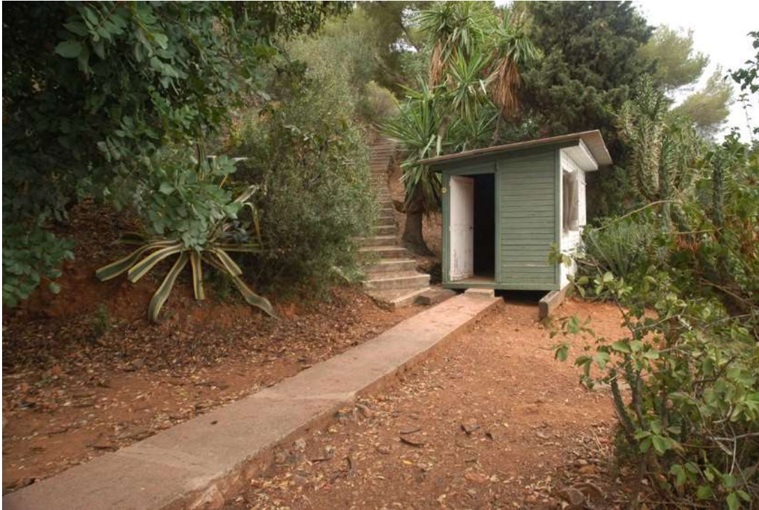
Abrigo de estaleiro de obra (2m×3m – 6m 2 ) (1954).
