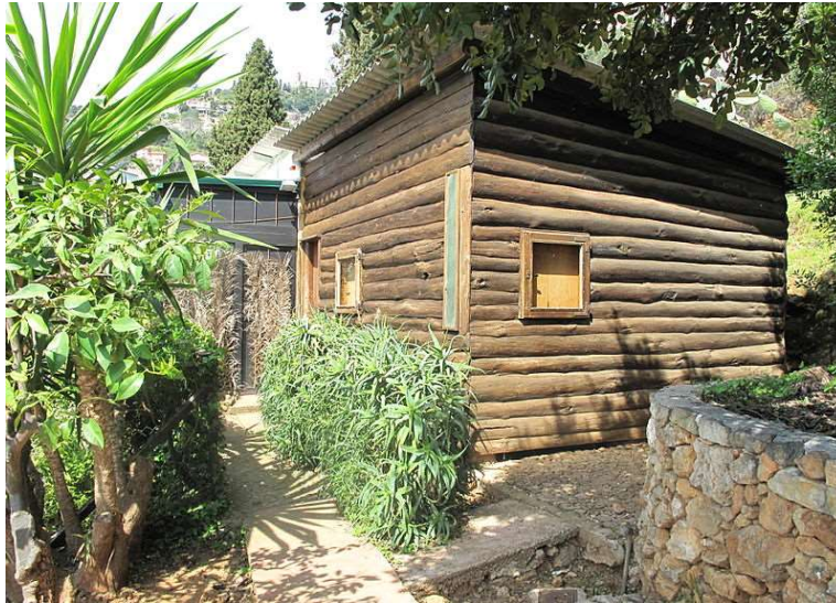
Le Petit Cabanon. (Fonte: http://arquiscopio.com/archivo/2013/09/03/petit-cabanon/?lang=pt )
