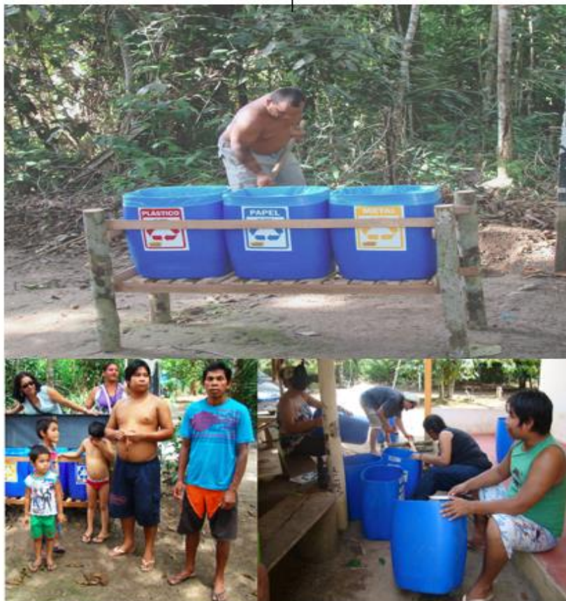
Figura L – Construção e fixação dos coletores de lixo na entrada
