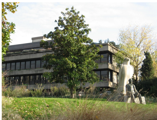
Figura 12. Fundação Calouste Gulbenkian – Lisboa. Vista Geral. (Fotografia: Teresa Madeira, 2007).
