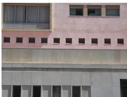
Figura 3. Hotel Ritz - Lisboa. O uso da pedra como material de revestimento nas fachadas. (Fotografia: Teresa Madeira, 2007).
