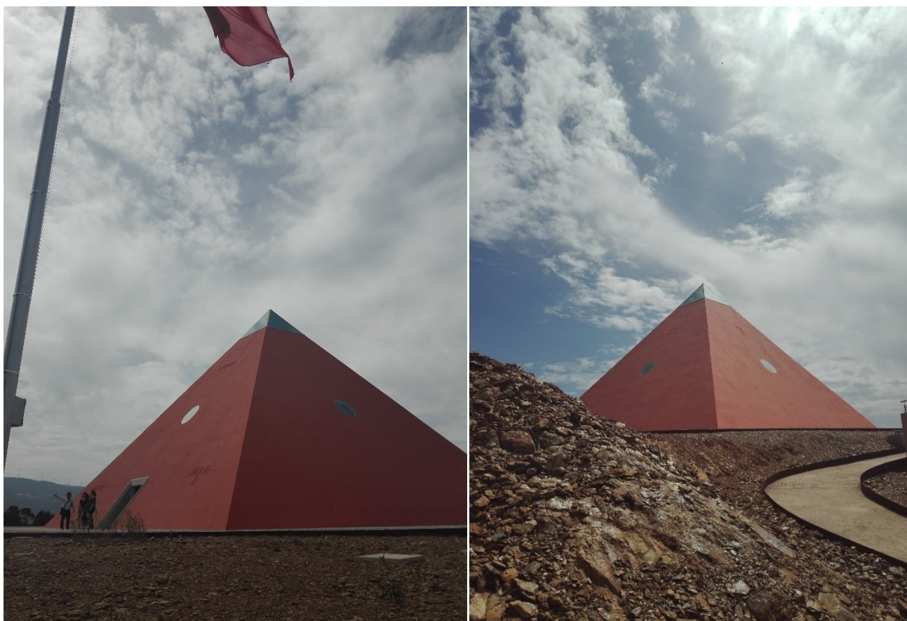
Figura 2 e 3 - Templo Ecuménico Universalista, fachada
