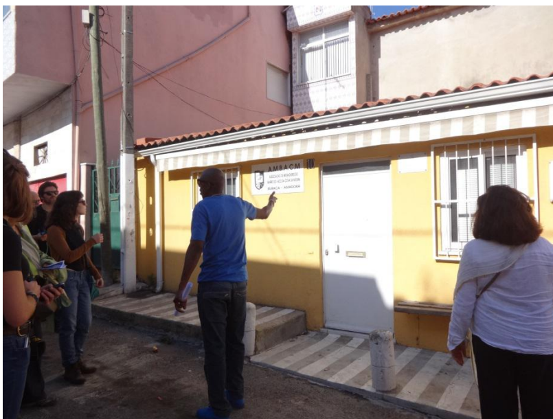
Figura 2 – Vista de edificado rehabilitado pela AMBACM, Cova da Moura (Fotografia de Ana Nevado, 2016).
