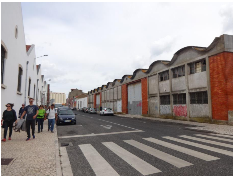
Figura 14 - Vista das instalações do Hub Criativo do Beato , no Beato (Fotografia de Ana Nevado, 2017).
