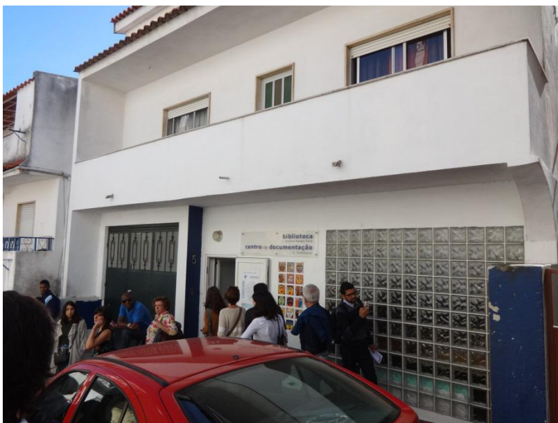
Figura 6 - Vista da Biblioteca e Centro de Documentação do Bairro da Cova da Moura – Associação Cultural Moinho da Juventude , instalado num antigo edifício habitacional entretanto reabilitado e adaptado para o efeito, Cova da Moura (Fotografia de Ana Nevado, 2016).
