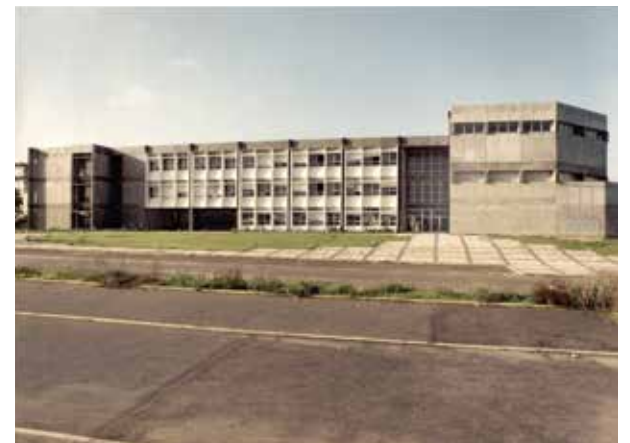
Desenhos do arquitecto Hestnes Ferreira para o projecto do ISCTE | Fachada do edifício inicial
