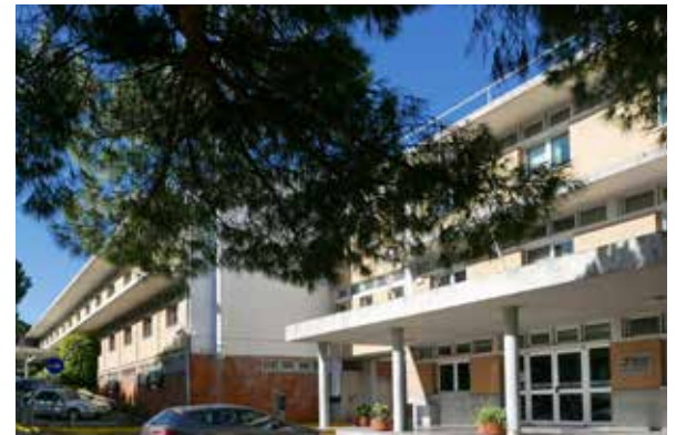
Instalações do IMTT (actual IMT)
