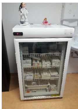
Figura 23 - Sala de vacinação (armazenagem de frio)
