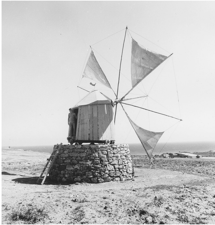
Foto 15 – O moinho começa a moer, após ter sido encarado ao vento
