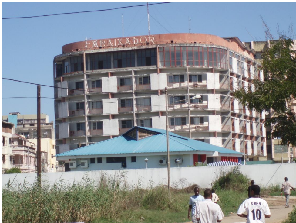
Fotografia 2 - Vista do Hotel Embaixador
