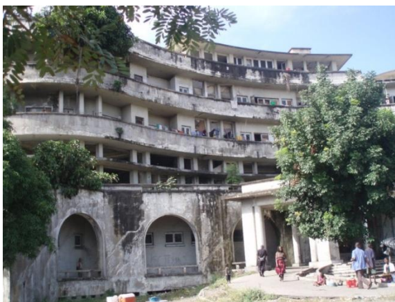
Fotografia: 4.4 - Ruínas do Grande Hotel
