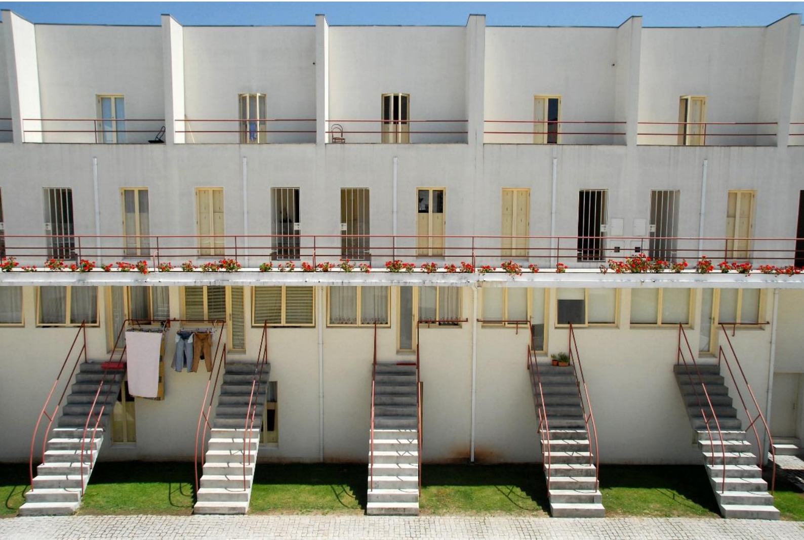
Fig. 47. Bairro da Bouça. Vista frontal das habitações de uma das bandas. Disponível em, commons.wikimedia.org
