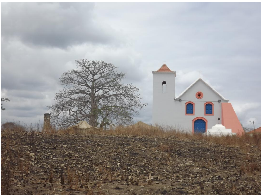
Fig. 23 - Vista exterior da Igreja após a renovação
