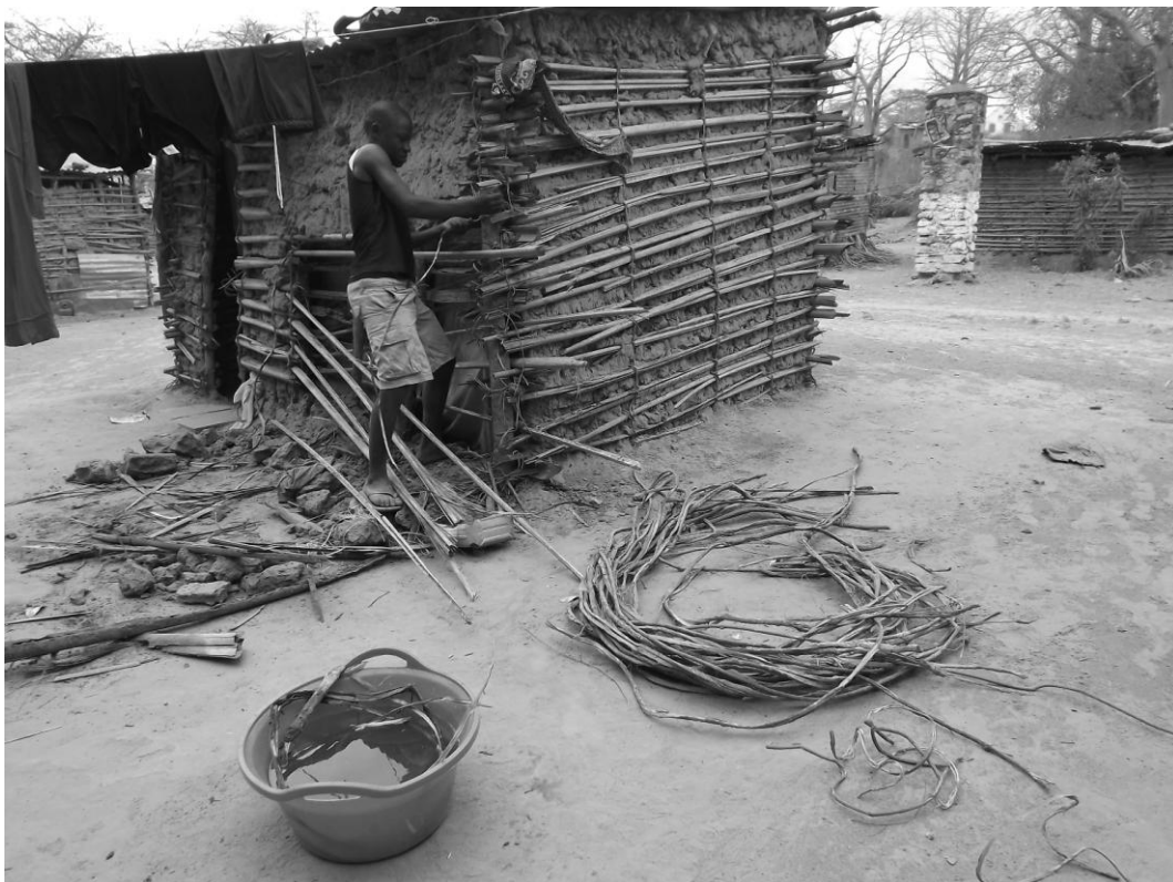
Fig. 13 - Reforço da estrutura da construção de pau-a-pique
