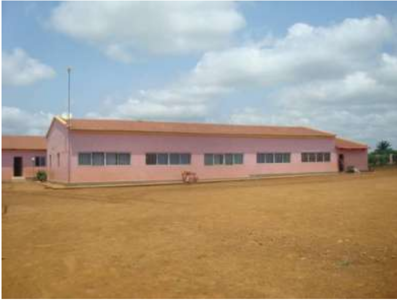
Pavilhão nº 2 do CAFGZ
